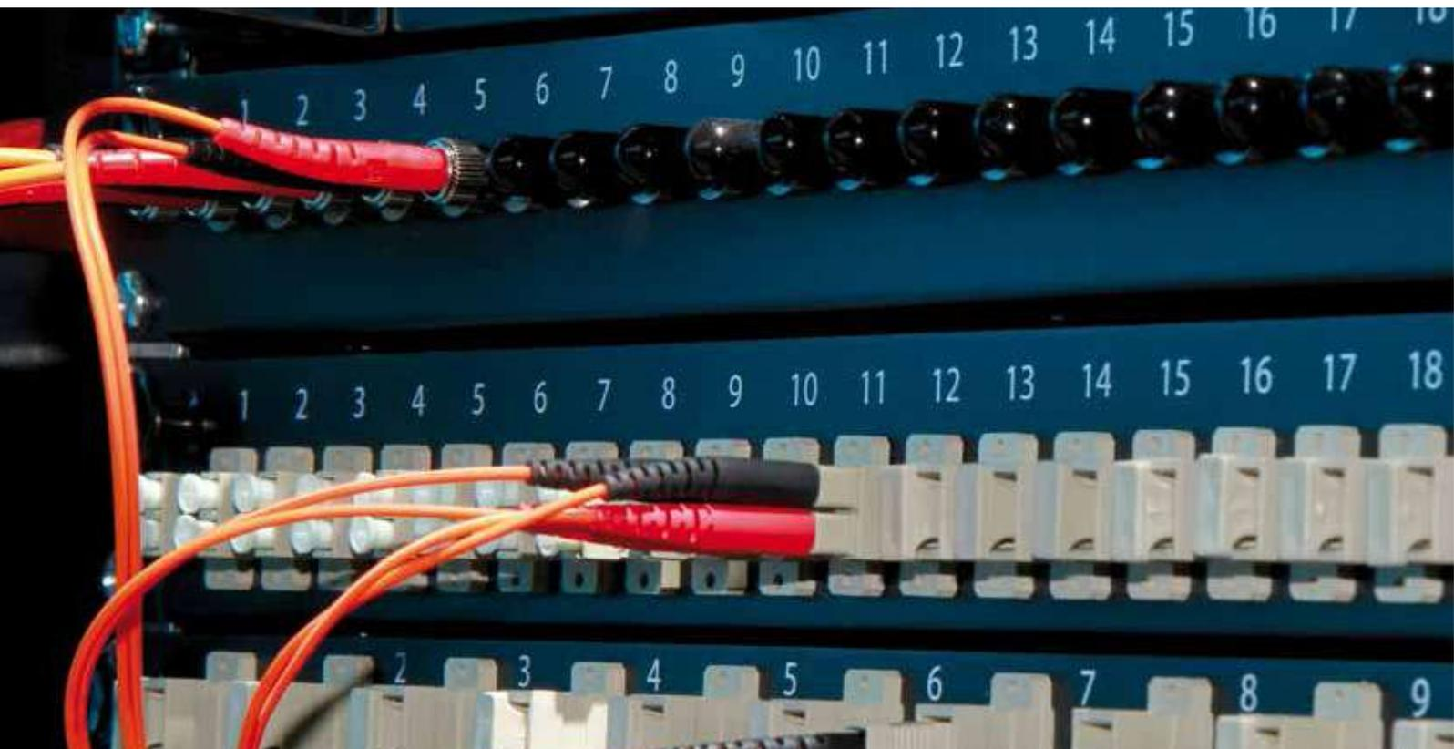
Utilizzati per la realizzazione di connessioni a lunga e breve distanza, i componenti del sistema di cablaggio ottico permettono di ottenere canali trasmissivi con banda elevata garantendo allo stesso tempo ingombri minimi ed immunità alle interferenze elettromagnetiche.
